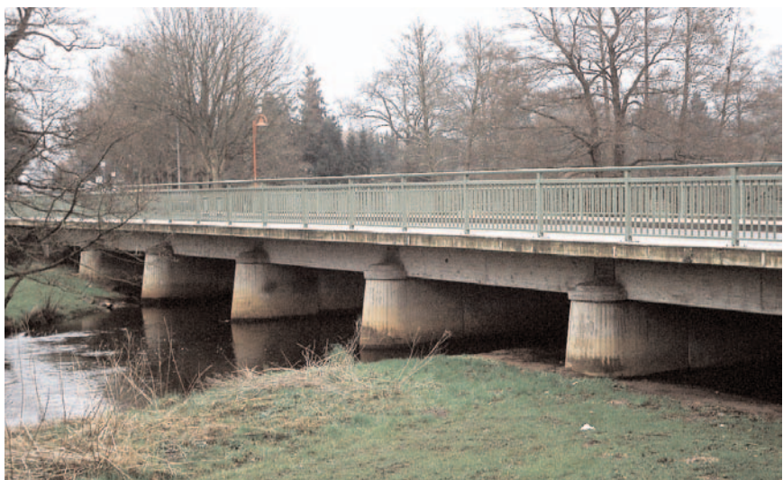
11 Für den Fischotter wie für andere Tierarten sollten Brückenbauwerke neben dem Gewässer auch immer einen Uferstreifen mit hindurchführen.
