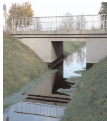
10 Brücken, die das Gewässer ohne einen Seitenstreifen unter der Brücke hindurchführen, verleiten Fischotter zum Queren der Straße und setzen sie damit den Gefahren des Autoverkehrs aus.
